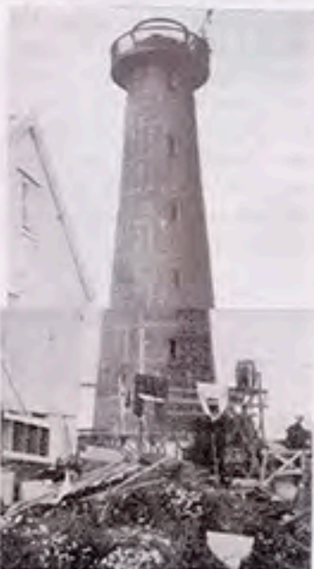
Tranøy fyr 1936. Tårnet er ferdig bygd og utstyr heises på plass. Foto: Ola Stokland.
